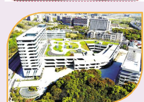
公交闸口停保基地迁建工程
