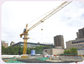
控制扬尘措施:塔吊喷淋、围挡喷淋、雾炮、裸土覆盖等
