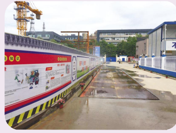
控制扬尘措施:塔吊喷淋、围挡喷淋、雾炮、裸土覆盖等
