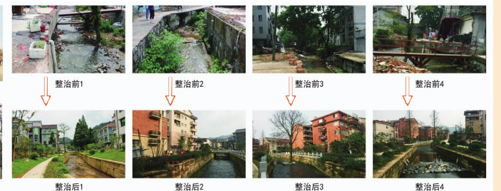
杨家牌楼溪整治前后对比图
